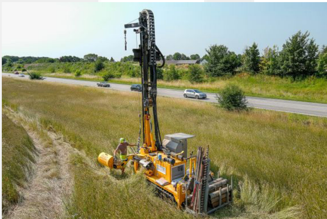
Boringer bliver udført med en særlig terrængående rig.
